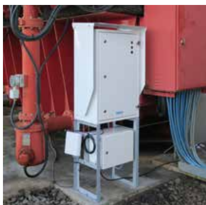
Figure 1. Le moniteur de gaz dissous en ligne OPT100. Les tuyaux d'entrée et de sortie d'huile sont raccordés aux vannes de vidange du bas.
