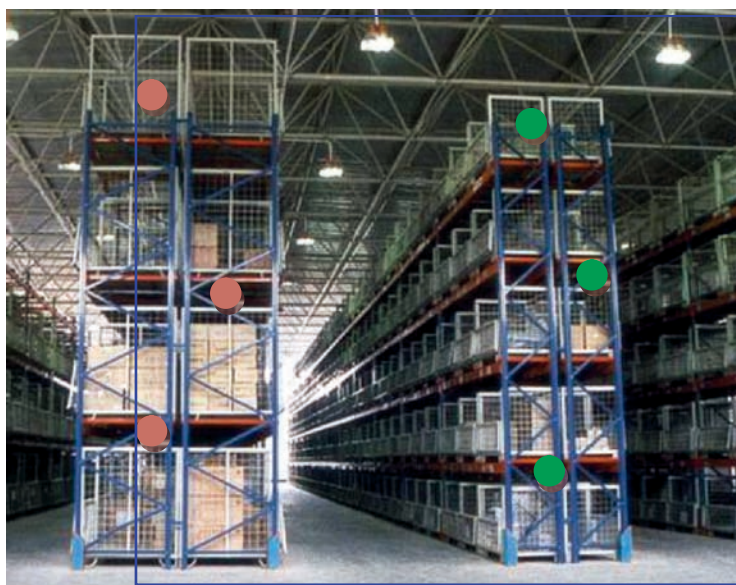
図2:ラックの真ん中に設置されたセンサは実際の製品温度を反映します。この例では、倉庫(30メートル×30メートル×15メートル)に置かれた二重ラックひとつひとつに9個のセンサが設置されています。
