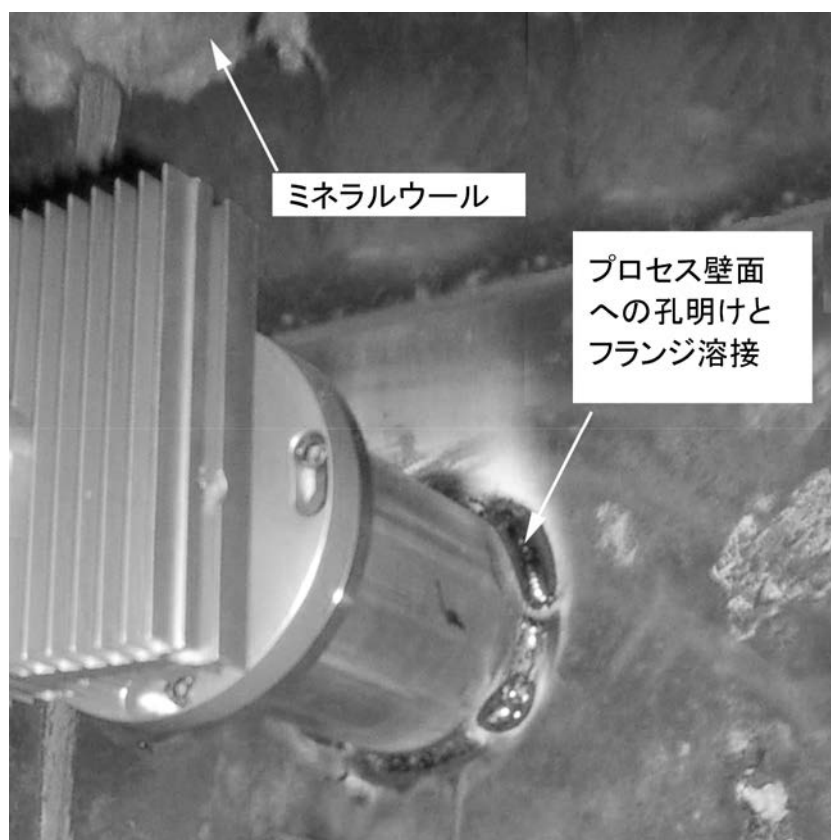
図 82 クーリングセットの取り付け
