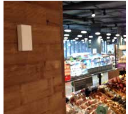
墙面安装型维萨拉 HMW90 系列变送器。
