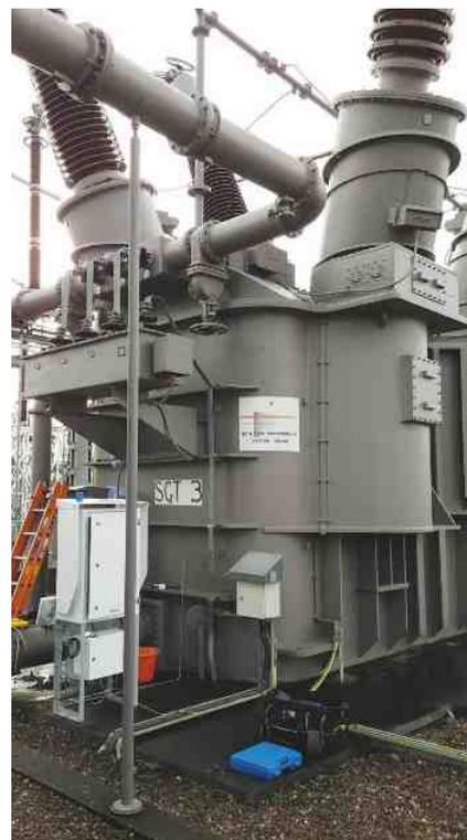
*El monitor con DGA Optimus de Vaisala instalado en el transformador de corriente.*
