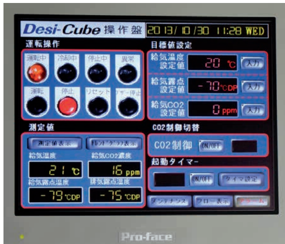
(株)西部技研 デシカント除湿機ディスプレイ(露点温度表示画面左下)
