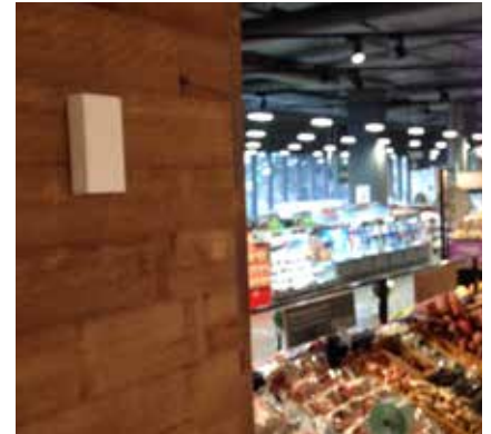
墙面安装型维萨拉 HMW90 系列变送器。
