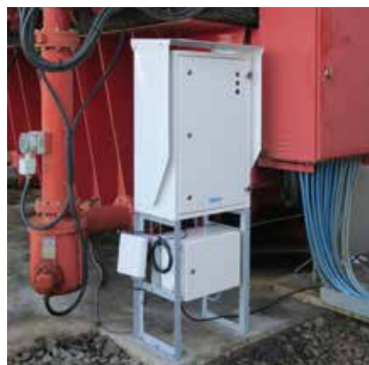
Figura 1. Monitor DGA OPT100 en línea instalado. Las tuberías de aceite de entrada y salida están conectadas a las válvulas de drenaje inferiores.
