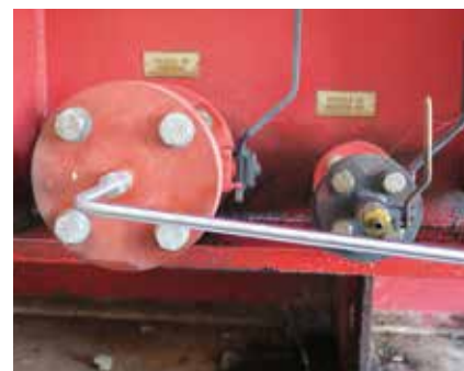
図1. 設置された Optimus™ OPT100 DGA常時監視装置。オイルインレットパイプおよびオイルアウトレットパイプは、下部にあるドレンバルブに接続されています。
