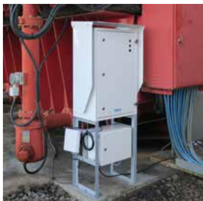
図1. 設置された Optimus™ OPT100 DGA常時監視装置。オイルインレットパイプおよびオイルアウトレットパイプは、下部にあるドレンバルブに接続されています。
