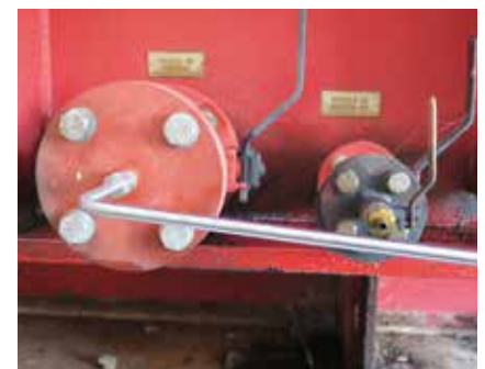
Figura 1. O monitor DGA on-line OPT100 instalado. Os tubos de óleo de entrada e saída são conectados às válvulas de drenagem inferiores.
