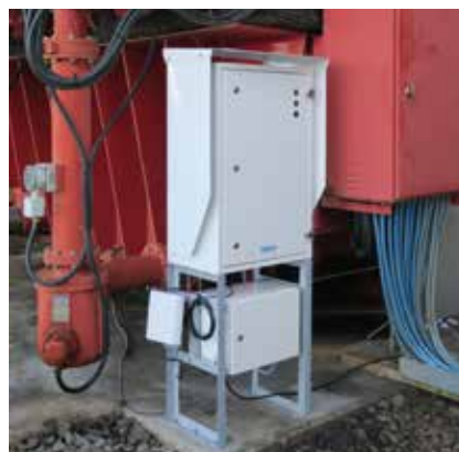
Figura 1. O monitor DGA on-line OPT100 instalado. Os tubos de óleo de entrada e saída são conectados às válvulas de drenagem inferiores.
