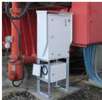
图 1. 安装的在线 DGA 监测系统 OPT100。进油管 and 出油管连接到底部的排放阀。
