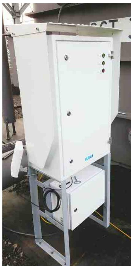
Ein weiterer entscheidender Vorteil des Vaisala OPT100 gegenüber anderen Überwachungslösungen für Transformatoren ist die einfache Installation: Elimpus und Scottish Power konnten dadurch das System sehr schnell ohne externe Unterstützung in Betrieb nehmen. Und da der OPT100 völlig ohne Verbrauchsmaterial auskommt, erfordert er auch keine eigene Wartung.
