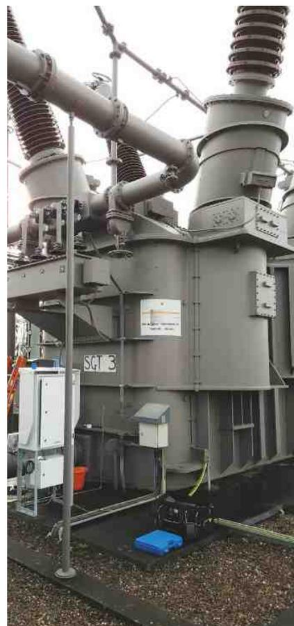
*Leistungstransformator mit installiertem Vaisala Optimus DGA Monitor.*
