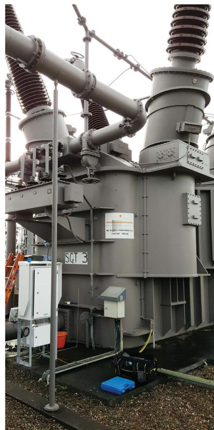
*Le moniteur Vaisala Optimus DGA installé dans le transformateur de puissance.*
