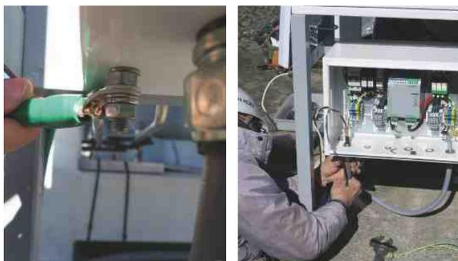
Schließen Sie Schutzleiter, Netzkabel und das interne Versorgungskabel an, und verbinden Sie das Ethernetkabel mit einem PC
