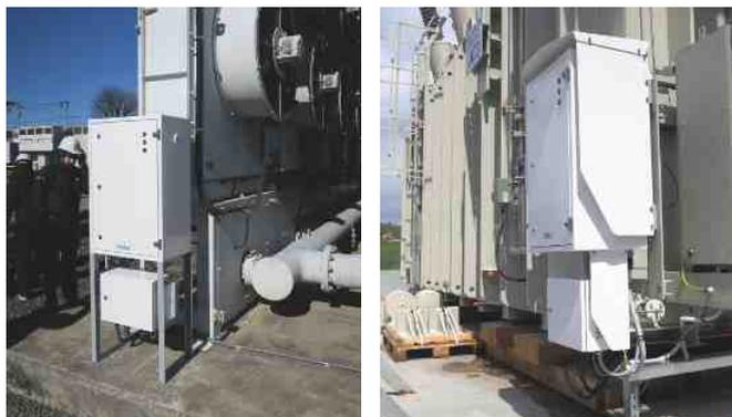
Sie können das Gerät am Boden oder am Transformator installieren
