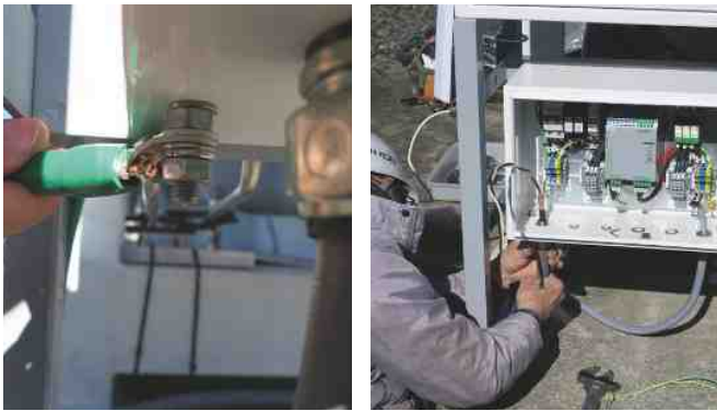
实现接地连接，连接直流电源线、交流电源以及将以太网连接到 PC
