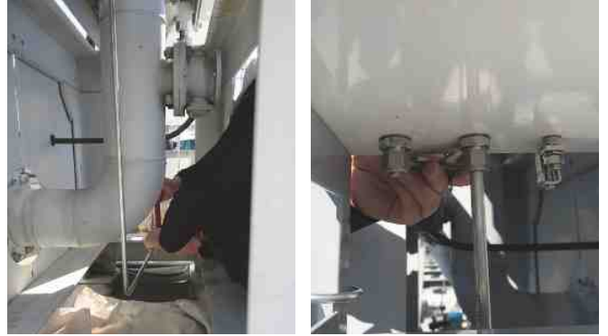
连接进油管 and 出油管
