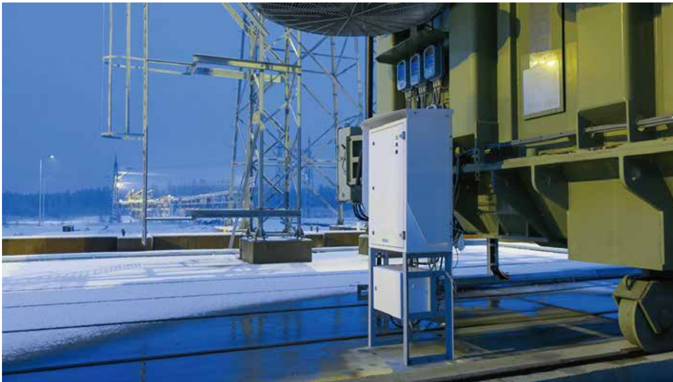
Optimus DGA 监测系统是在恶劣环境下保护关键变压器的合适解决方案
