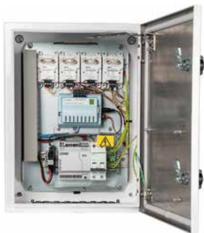
CAB100支持内部压差变送器、模拟量输入和安全栅或电流隔离器。
